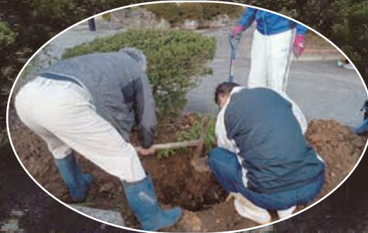
(小・中学校運動場点検・整備)
